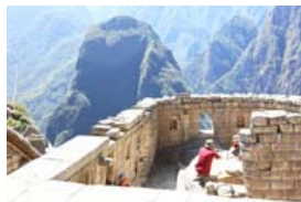
天空の神殿での作業状況
